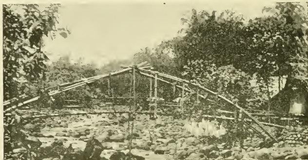
Fig. 6. — Un pont de bambou sur le Tjiliwong, à Buitenzorg.
