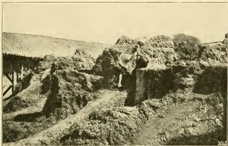
Bild 8. Der Salpeter wird mit Wasser ausgelaugt.
