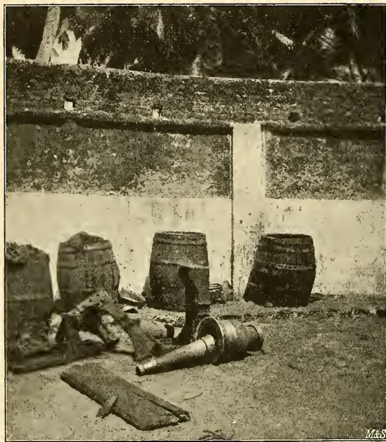
Bild 2. Eisen-Mörser und Pistill einer Kokosölmühle in Cochín.
