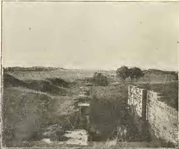
FIG. 4. — L'ancienne écluse de Fort-Mardyck.
