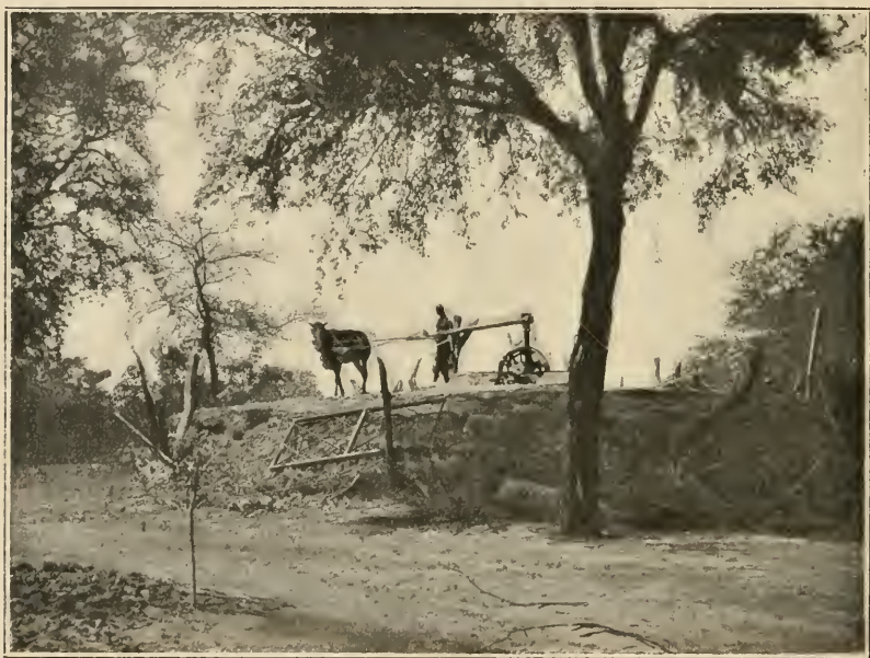
Pompe à chapelet, en marche à l'ouest de la station irriguant AB et \frac{2}{3} de B C.
