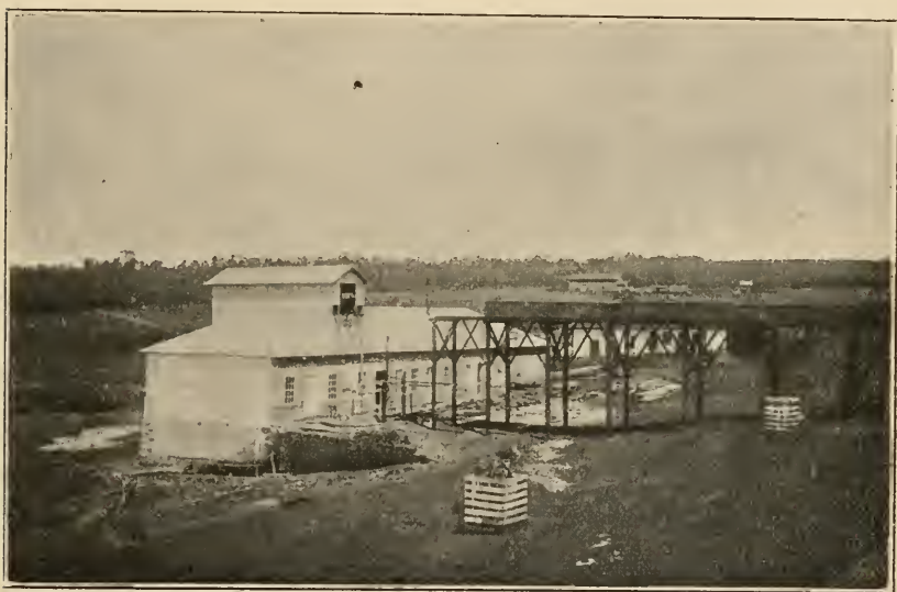
Usine à décortiquer le café des plantations Schmidt. Le café arrive par le haut du bâtiment.
