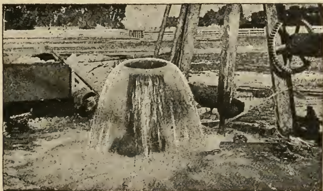
FIG. 350. — Extrémité du tube d'ascension d'un puits artésien.
