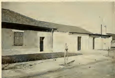
ESTACION DE BIOLOGIA MARINA Y TECNOLOGIA PESQUERA, PUERTO MAR DEL PLATA
