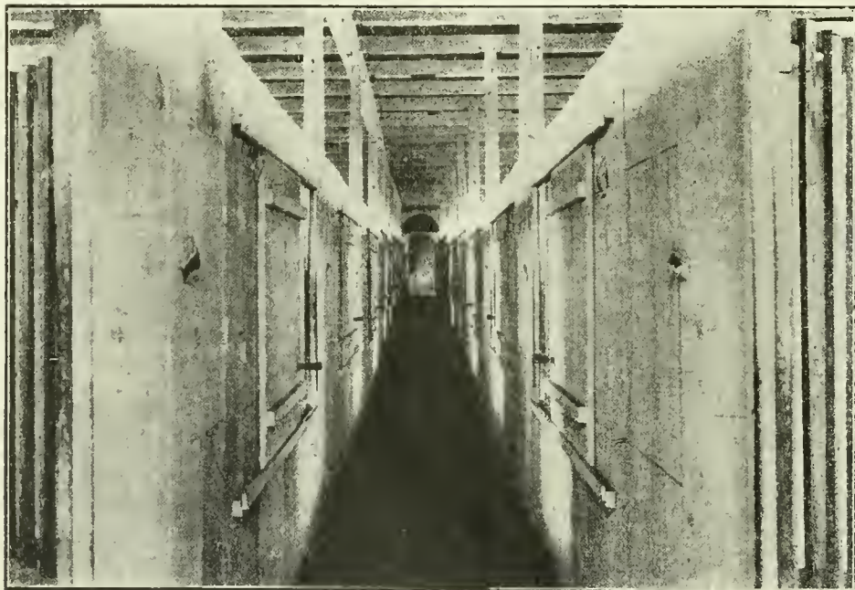
Interior das cocheiras da Coudelaria "Carlos Dietzsch" — Curitiba, Paraná — (Construção toda de madeira — pinho)
