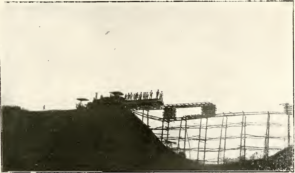
Aterro da linha ferrea construida pela Usina
