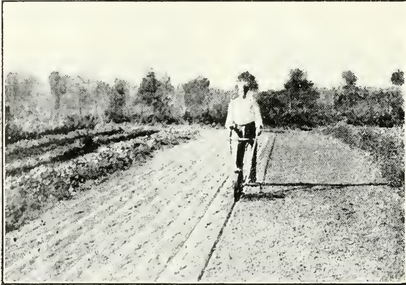
Uma semeadeira de mão, moderna. Abre o sulco, deita a semente, cobre-a, comprime a terra e marca a carreira seguinte, ao mesmo tempo.
