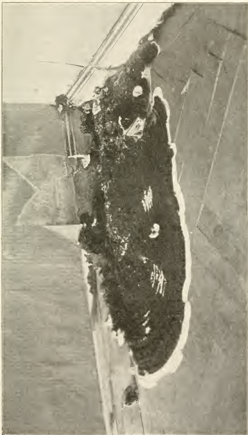
Merulius -Fruchtkörper in der Ecke eines Parterrezimmers auf gesundem Eichenparkett, aus dem darunterliegenden zerstörten Nadelholz-Blindboden hervorwachsend. Ungef. 1 : 10 nat. Gr. (Nach Photographie.)
