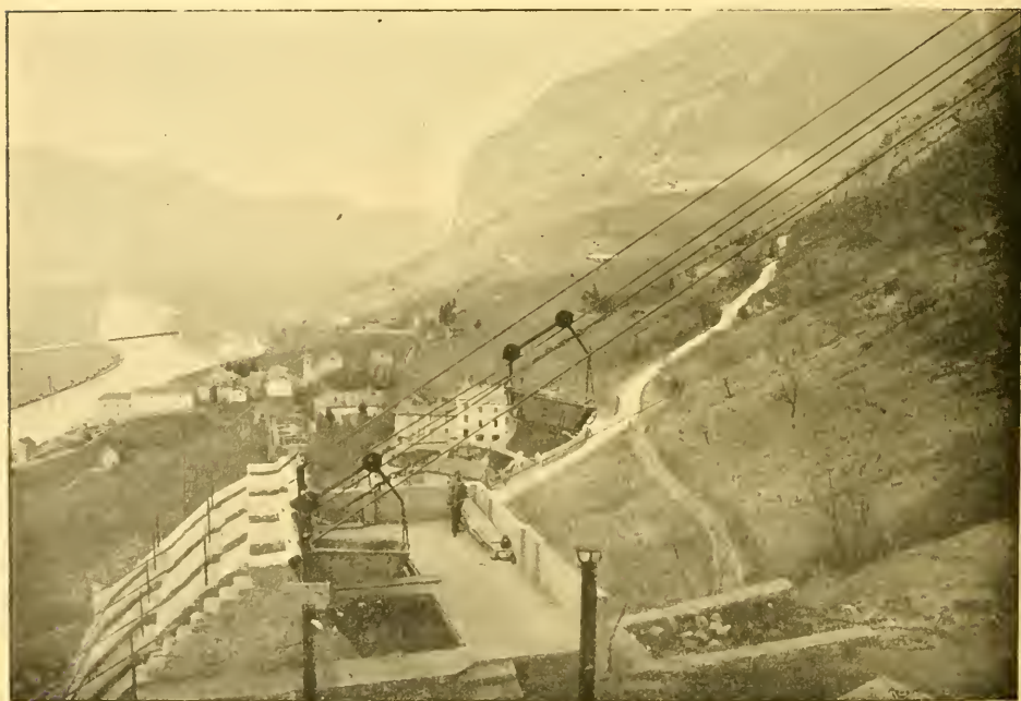
Fig. 17. — Transport des pierres à ciment du Mont Jalla à l'Usine de Ciment de la Porte de France. — Gare d'arrivée.
