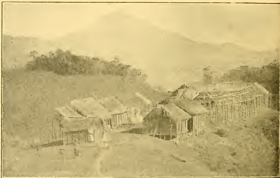
Fig. 10. — Village de Bâcherons, à la lisière de la grande forêt de l'Est.
