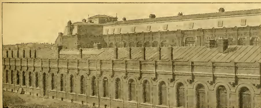
Fig. 6. — Facade postérieure de l'Institut de Chimie.
