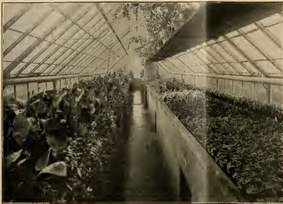
Blick in das Warmhaus der städt. Gewächshausanlage in Offenbach a. M.
