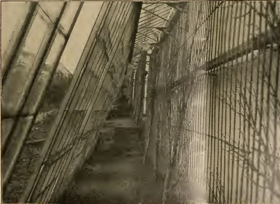
Innenansicht aus der Talutmur im Schloß Friedrichshof, von Osten nach Westen gesehen.
