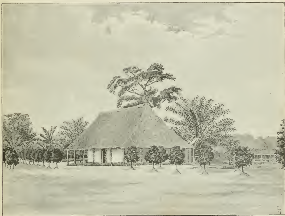
LE POSTE DE SOLDATS DE BOLOMBO.
