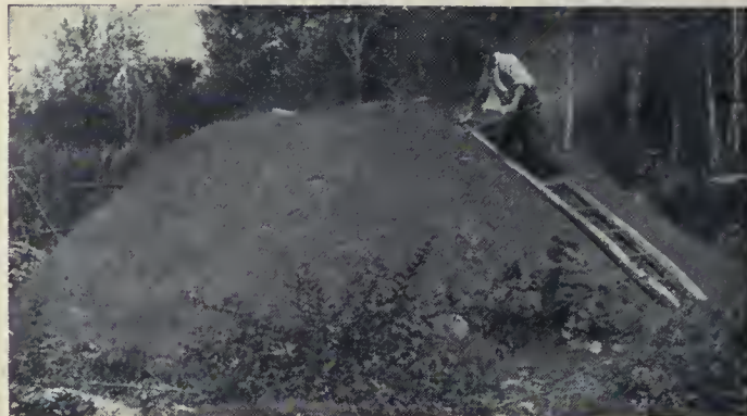
Fabrication du charbon de bois : Construction d'une meule et ouverture des événements dans une meule terminée.
