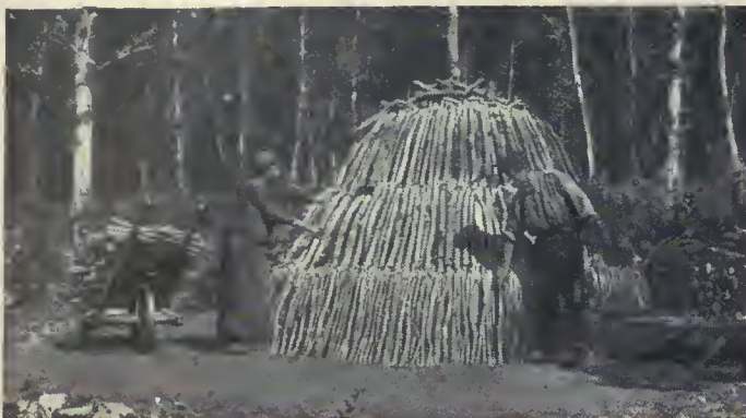
Fabrication du charbon de bois : Construction d'une meule et ouverture des événements dans une meule terminée.
