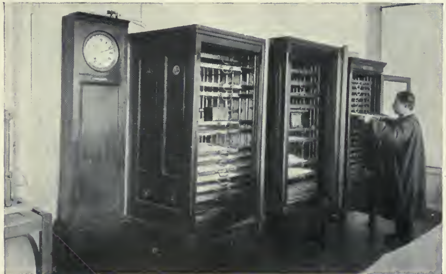
Étuves Schribaux pour l'étude du pouvoir germinatif des graines.
