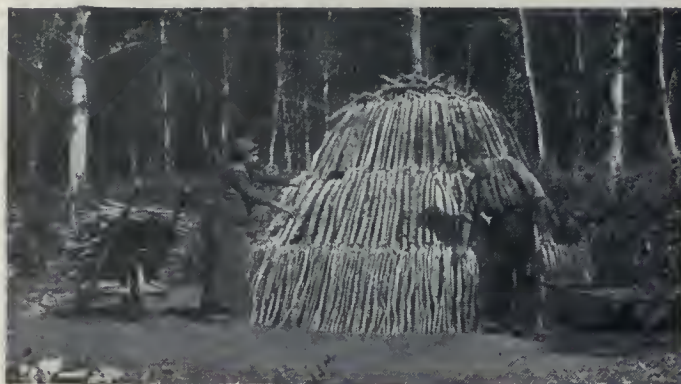
Fabrication du charbon de bois : Construction d'une meule et ouverture des événements dans une meule terminée.
