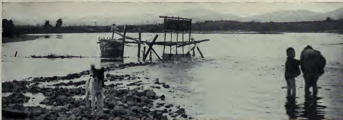
Un moulin à eau pour piler le riz, à Cao-Binh (Tonkin).
