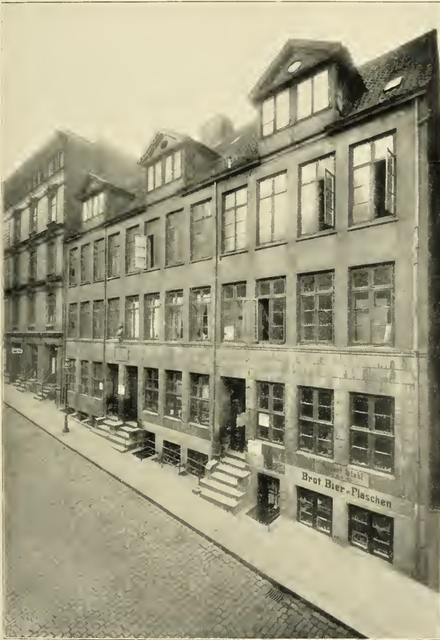
Fig. 8. Ansicht der Häuser Königstraße Nr. 52, Nr. 50 (Klopstockhaus) und Nr. 48 vor dem Abbruch, Herbst 1908.
