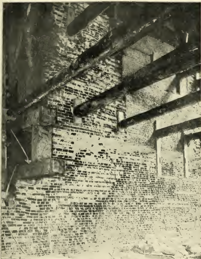
Fig. 3. Fundamentreste des Steintors. Aufgedeckt 1908.
