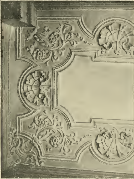
Fig. 10. Stuckdecke aus dem Hause Königstraße 48. Erstes Drittel des 18. Jahrhunderts.
