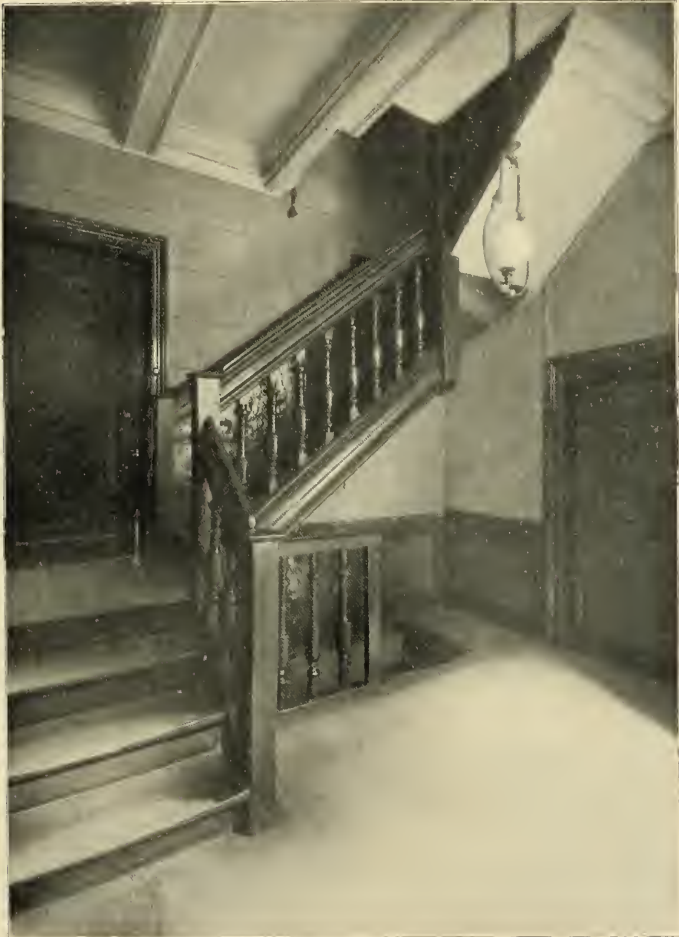
Fig. 12. Flur des Klopstockhauses, Königstraße 50.
