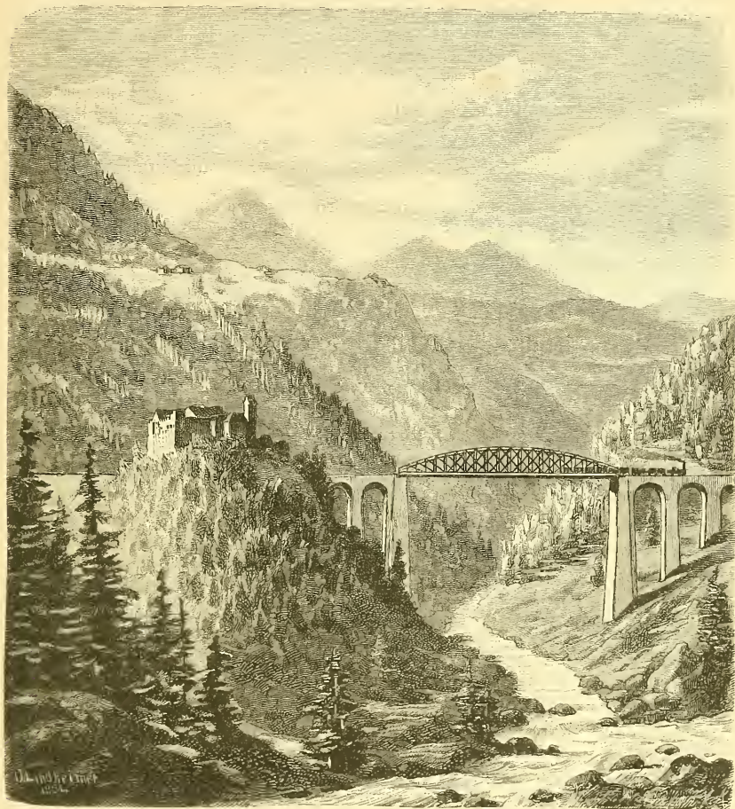
Der Trissanna-Viadukt auf der Arlbergbahn.
