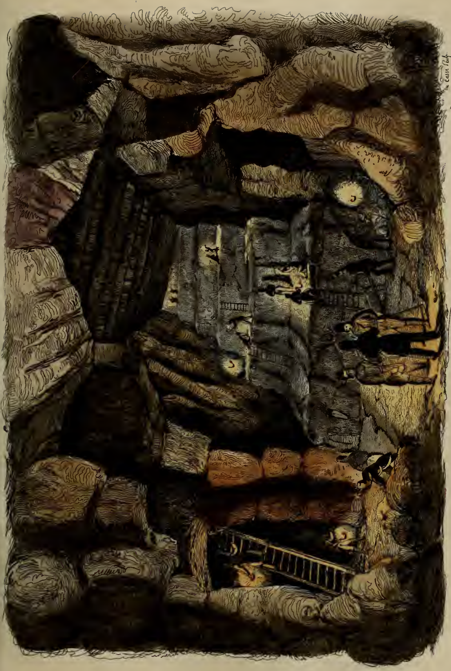
Exploitation par gradins d'une Mine de Plomb. Argentière des environs de Clausthal au Harz.
