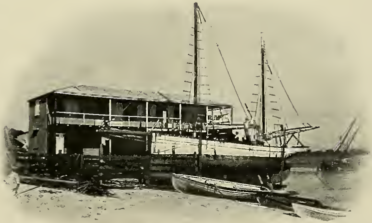
Die „Marie“ in Reparatur.
