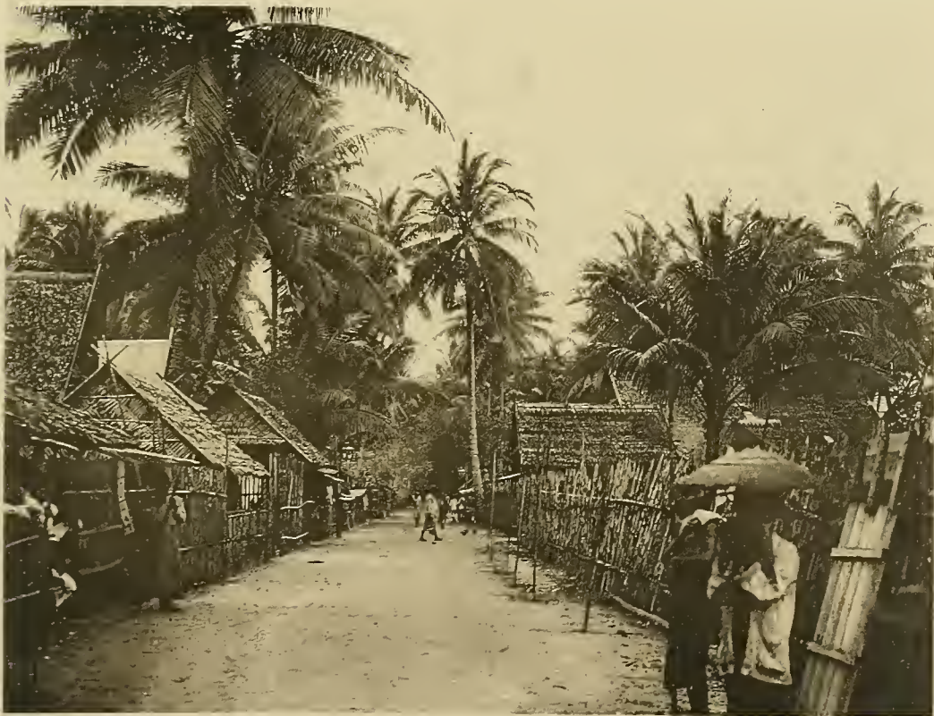
Strasse im Buginesenviertel von Dobo.
