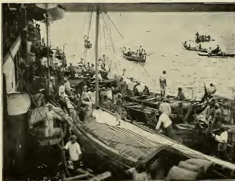
Kurz vor der Abfahrt.
