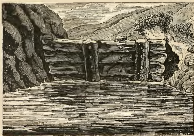
FIG. 309. — Vue d'un petit barrage en bois maintenu par des pilots.
