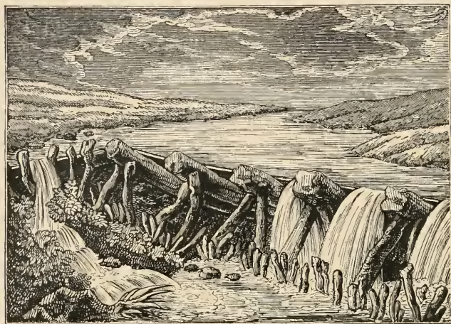
FIG. 308. — Vue d'aval d'un petit barrage en bois soutenu par des chevalets.
