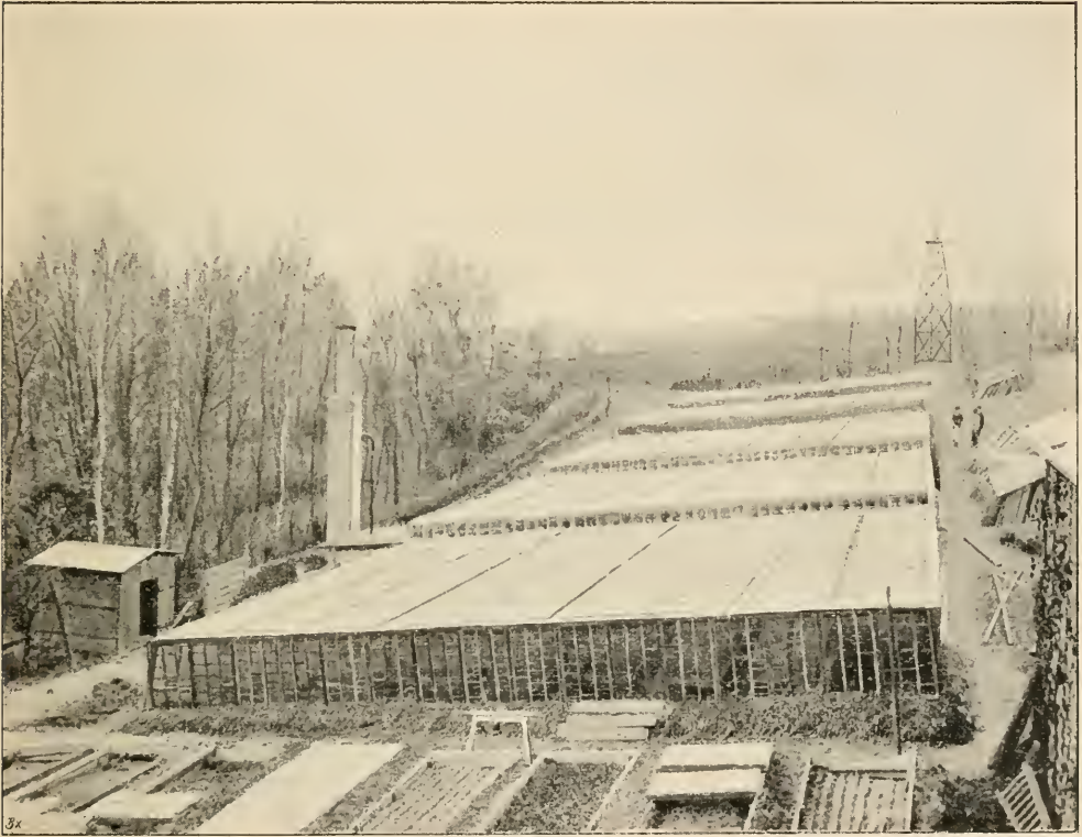
Abb. 1. Die „Fortschrittsbude“ des Herrn Carl Kotte, Südende b. Berlin, aus Mistbeetfenstern erbaut, 75 m lang, 15 m breit. Photographiert von L. Wittmack (bei nebeliger Luft aufgenommen).
