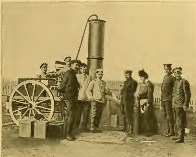
Fig. 3. — Dispositif pour la stérilisation de l'eau au moyen de l'ozone, en fonctionnement sur le théâtre de la guerre russo-japonaise.
