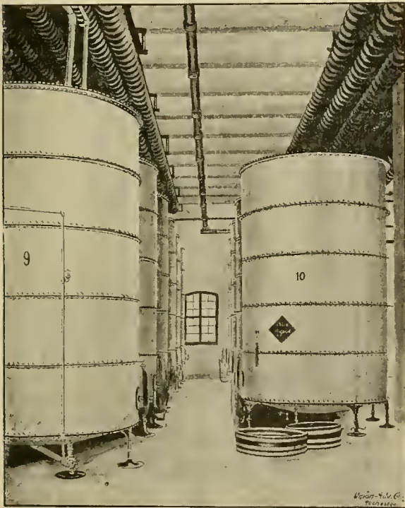
Fig. 3. — Cylindres en fonte émaillée servant à la fermentation du moût dans le vide, d'après le système Pfaudler.
