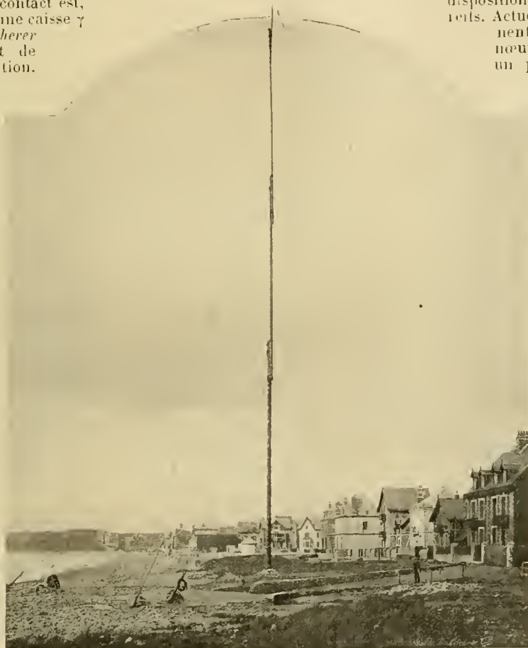
Fig. 4. — Mât de 50 mètres de hauteur pour soutenir le fil expéditeur ou récepteur des oscillations électriques, à Wimereux. — Vers la droite, chalet où sont contenus les appareils de la figure 1. (Photographie de M. Lormier, de Boulogne-sur-Mer.)
