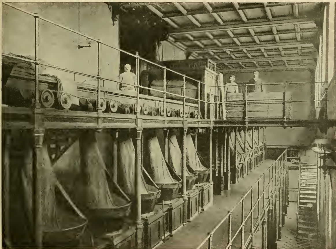
Fig. 2. — Atelier de râpage (fabrication du tabac à priser) à la Manufacture de Pantin. — Le tabac, après avoir passé dans le blutoir qu'on aperçoit dans la cage du haut, est amené, par une vis sans fin régnant dans toute la longueur de l'étage supérieur, au-dessus des moulins, dans lesquels il se déverse par des gaines en toile. Après avoir subi l'action des moulins, le tabac est repris au-dessous et transporté par une noria, qui est derrière la figure, dans le blutoir du haut, qui sépare le tabac bien râpé du tabac trop gros, lequel repasse aux moulins. Le cycle est ainsi fermé, et il suffit d'alimenter de tabac nouveau un ou deux moulins de la rangée.
