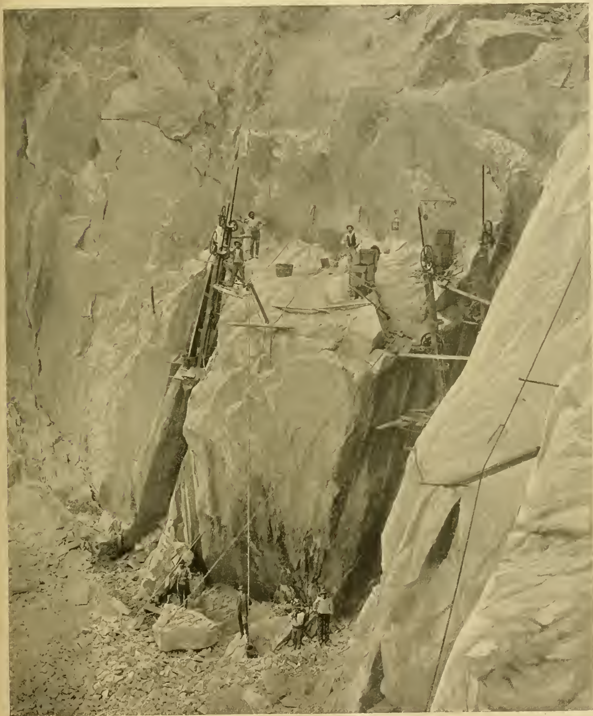
Fig. 2. — Sciage dans la roche, dans la carrière de marbre de « Cava Torrione », à Carrare (Appartenant à M. Faggioni)
