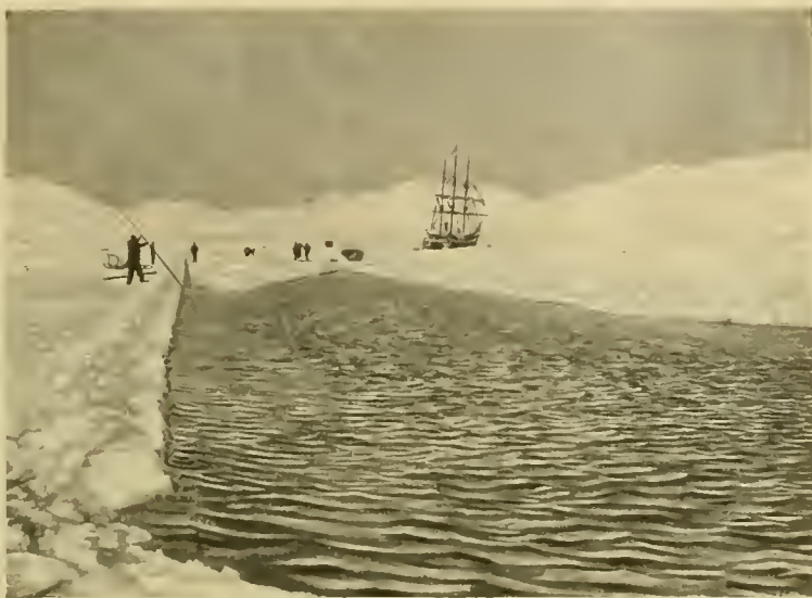
Fig. 7. — Canal artificiel de 700 mètres de longueur, scié dans la glace de mer de 1 m .70 à 2 mètres d'épaisseur, en Janvier et Février 1899, pour dégager la Belgica du champ de glace dans lequel elle est restée emprisonnée toute une année et avec lequel elle a subi une dérive totale de 3,000 kilomètres. Photographie de l'Auteur.
