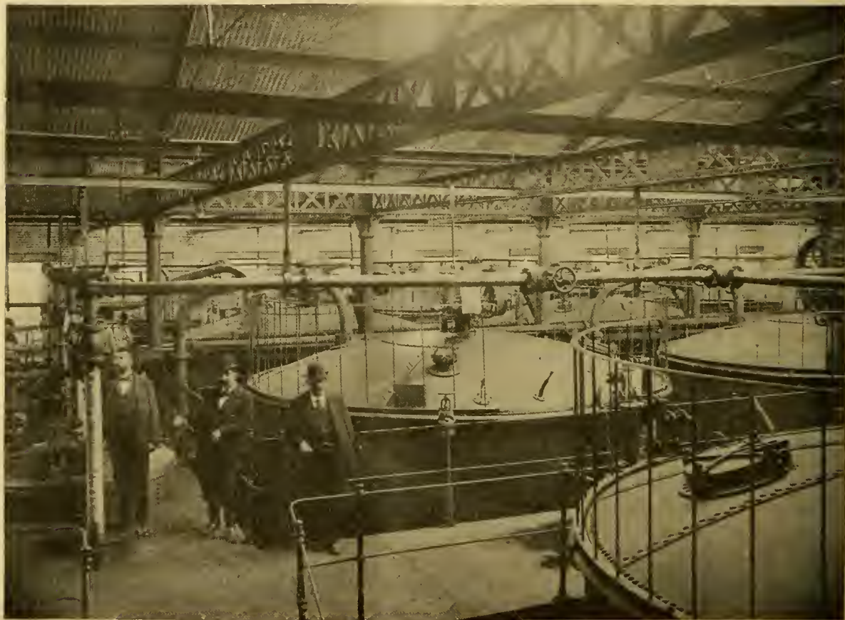
Fig. 2. — Installation de seize cuves de fermentation de 1100 hectolitres,
