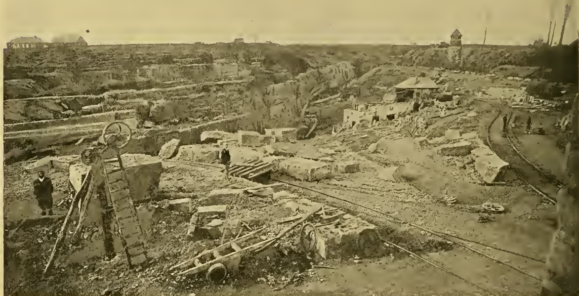
Fig. 1. — Carrière de marbre à Hon-Hergis (Nord), appartenant à M. Blondeau.
