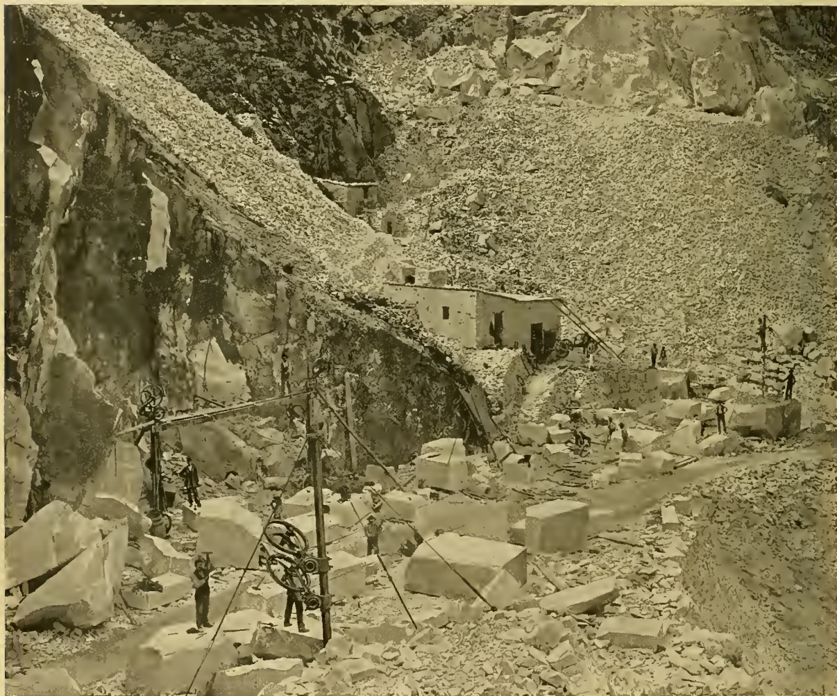
Fig. 3. — Vue de la scie hélicoïdale en action dans la carrière de marbre de « Cava Torrione », à Carrare (Italie).
