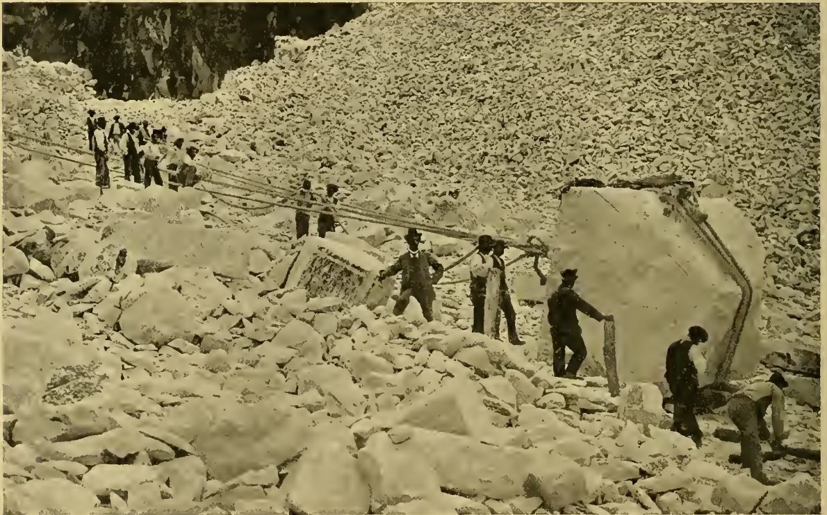
Fig. 6. — Descente d'un bloc de marbre de la carrière d'extraction au lieu de gerbage.
