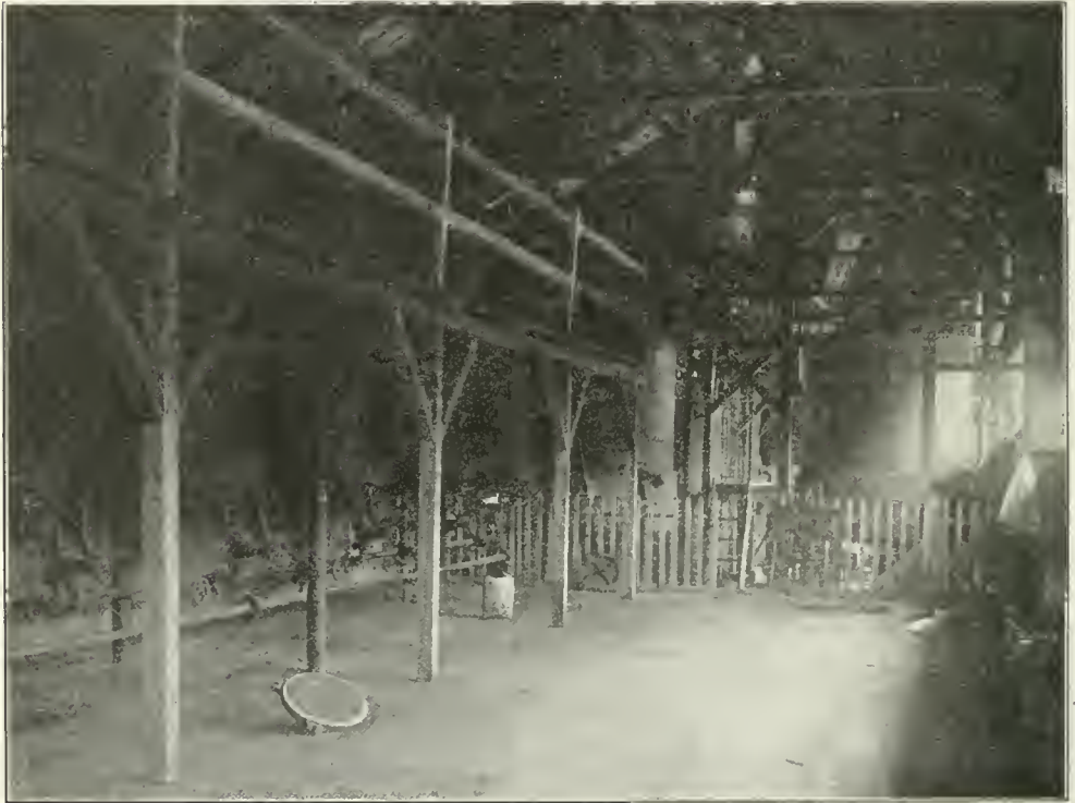
Fig. 115. Een kijkje in de extractiefabriek te Soekaboemi.
