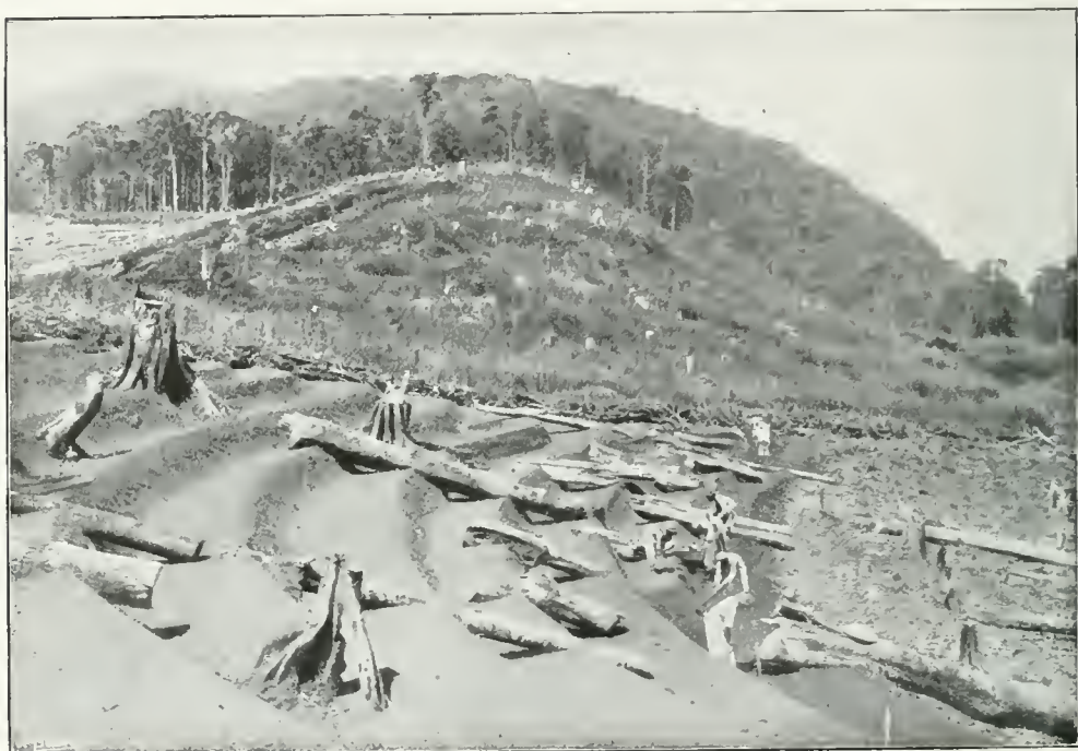
Fig. 89. Aanleg van terrassen op nieuwe ontginning.
