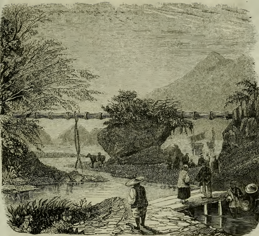
Eine Wasserleitung in China aus Bambusrohr.
