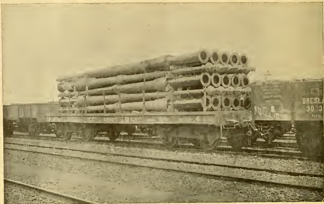
Fig. 9. — Poteaux pour électricité soudés au gaz à l'eau chez W. Fitzner, à Laurahutte.
