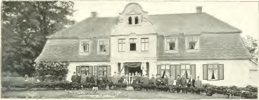
Serrenhaus in Hohenfelde. Besuch der D. L. G.
