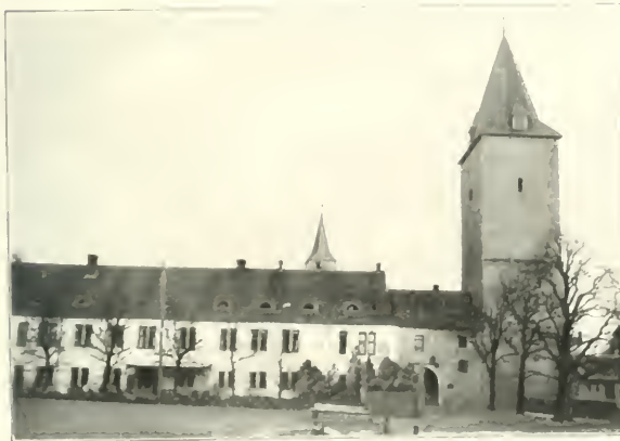
Wohnhaus des Pächters.
