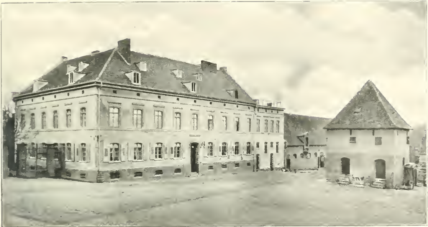
Wohnhaus der Domäne Gröbzig.
