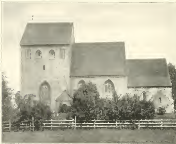
Kirche Wattmannsbagen bei Kalendorf, im 13. Jahrhundert erbaut und noch zum Teil aus dieser Zeit erhalten.
