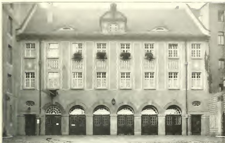
Betriebsgebäude der Weinbaudomäne in Mainz.
