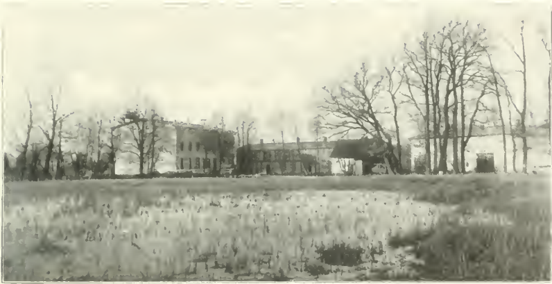
Gesamtansicht der Niedermühle.
