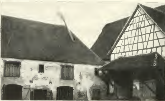
Außenansicht eines Gebäudes, in das Strohhäckel von der nebenstehenden Scheuer mit Doppeltenne befördert wird. Zur Demonstration ist das Rohr-ende, aus dem der Häckel herausfliegt, durch das Dach gelassen.
