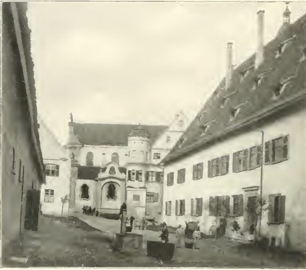
Links Pferde- und Ochsenstall mit Magazin für Handgeräte, Runttdünger- und Wagenteile, sowie Schmiede, rechts Wohnhaus mit Wagenwerkstatt, Obstkellerei und Speicher.
