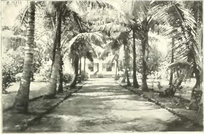
Direktionsgebäude am Katakafafen.
