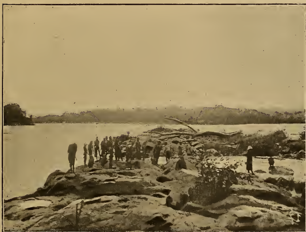
FIG. 106. — Barrage de diabase entre Bangui et Fort-de-Possel.
