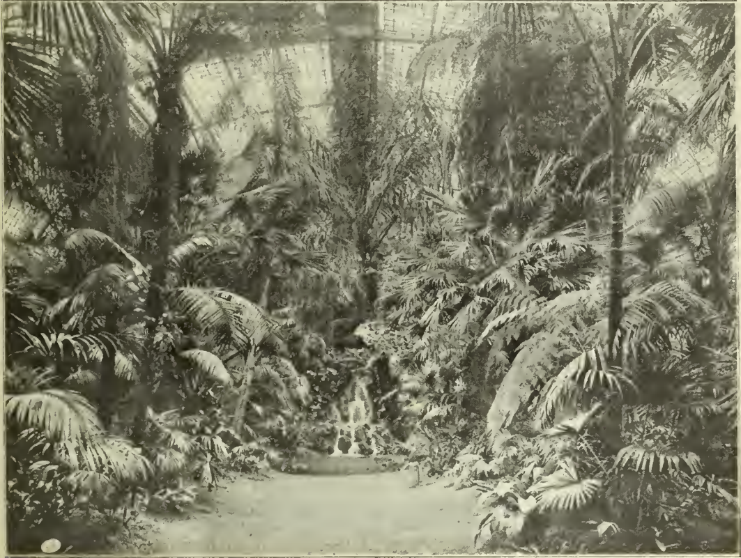
Fig. 153. — Grande serre des Palmiers au Palmengarten de Francfort.
