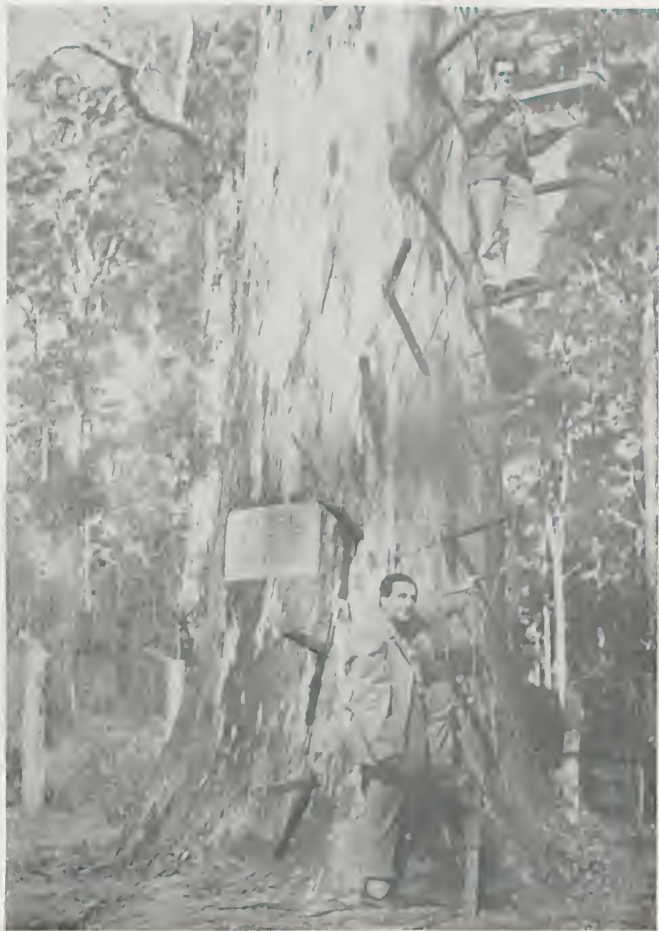
Torre de vigia, com 60 metros de altura, construída no topo dum Eucalyptus diversicolor em plena mata, para observação de incêndio. Nesta foto, gentilmente cedida pelo Professor A. De Philippis vemos o Dr. Chienesi, representante da Itália, e o autor.
