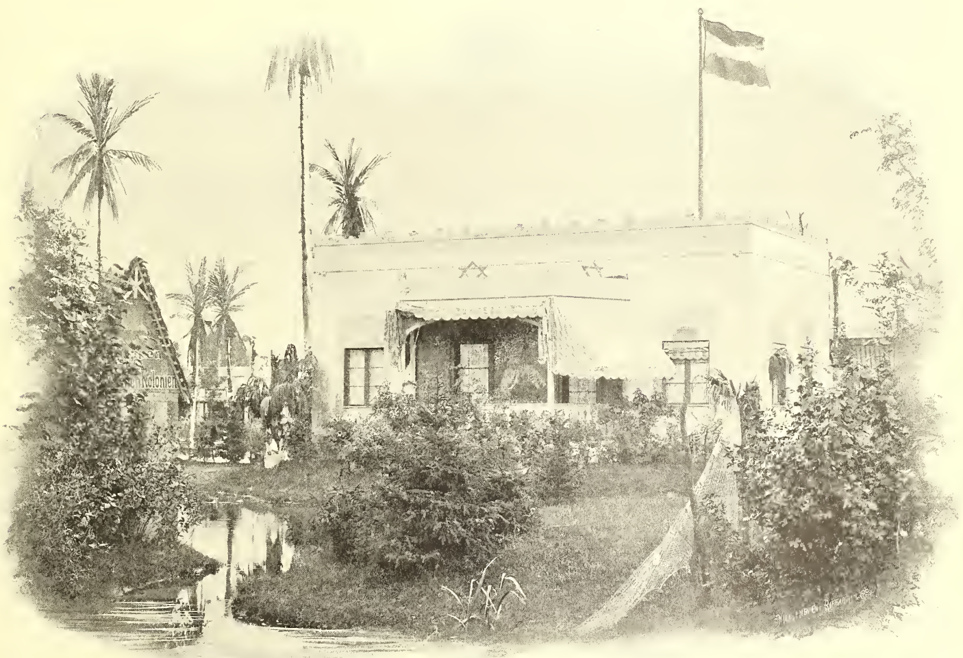
Gebäude des Arbeitsausschusses (Rückseite).
