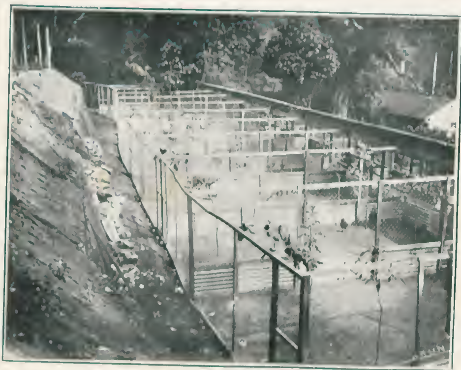
Uma das instalações do « Ascurra Basse Com »
