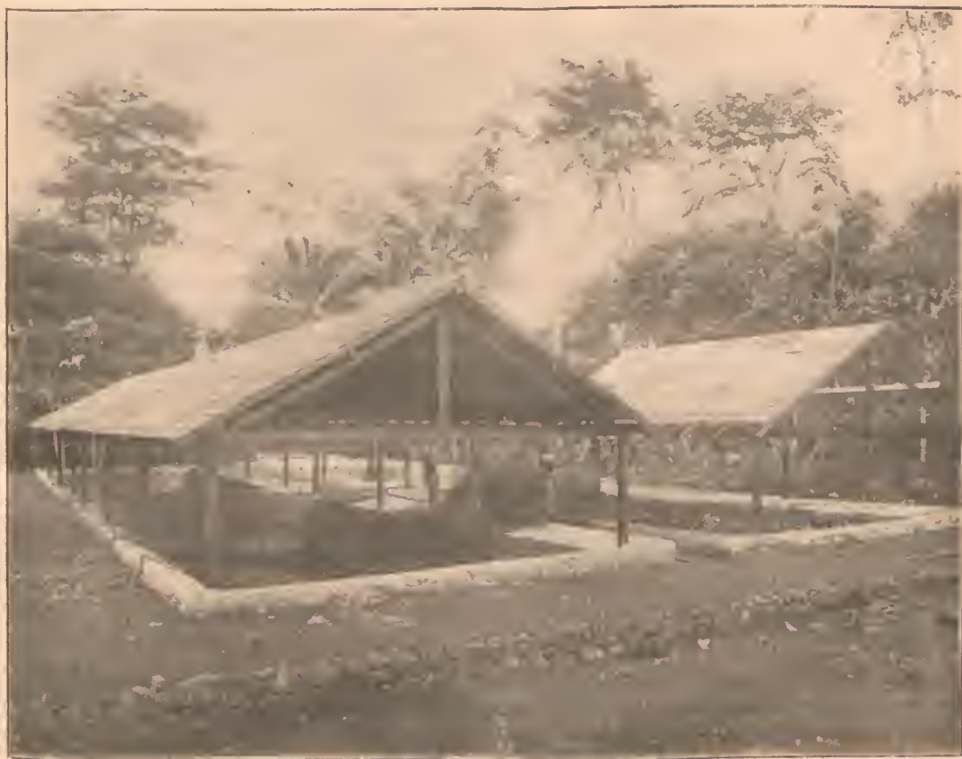
Fig. 1. — Vue des fosses à fumier de « Boa Entrada », San Thomé. Chaque fosse est de 100 mètres cubes. L'ensemble est desservi par wagons sur voie étroite.
