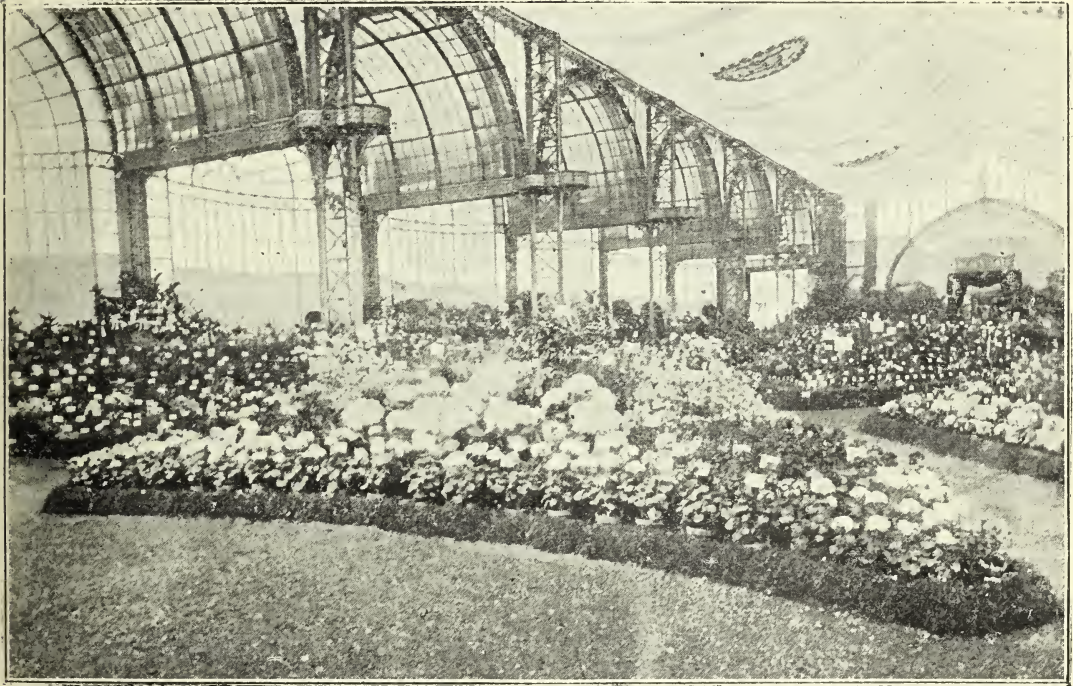
Fig. 113. — Vue d'ensemble de la serre de l'Alma à l'Exposition du Cours-la-Reine.
