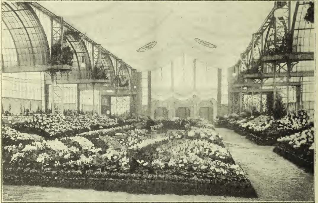
Fig. 198. — Vue de la serre des Invalides à l'Exposition du Cours-la-Reine.
