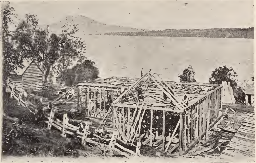
Fig. 43.—Construcción de una casa en Llanquihue
