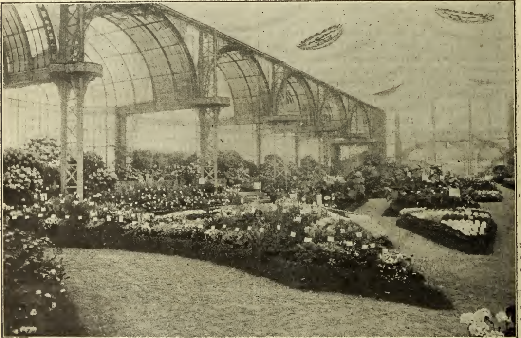
Fig. 87. — Vue d'ensemble de la serre des Invalides à l'Exposition du Cours-la-Reine.
