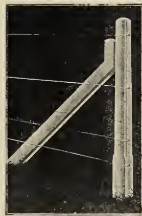
Fig. 41. — Poteau raidisseur avec jambe de force.
