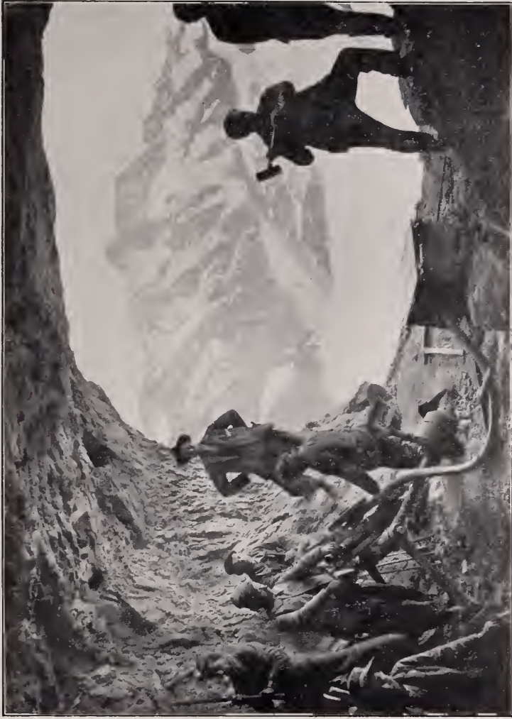
FIG. 19. — TRAVAUX D'EXCAVATION EXÉCUTÉS A L'USE DES FENÊTRES DE LA STATION D'EISMER. PERFORATRICE A PERCUSSION DE SIEMENS ET HALSKE ET SON MOTEUR ÉLECTRIQUE.
