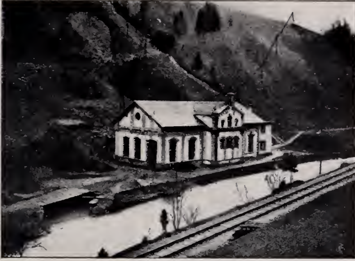
FIG. 20. — STATION HYDROÉLECTRIQUE DE LAUTERBRUNNEN.
