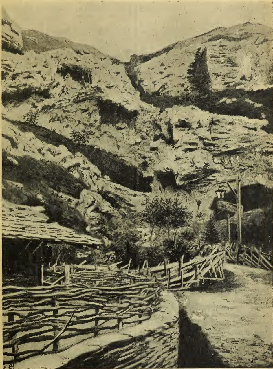
Fig 167. — Au Village suisse : vue de la même partie rocheuse après revêtement.
