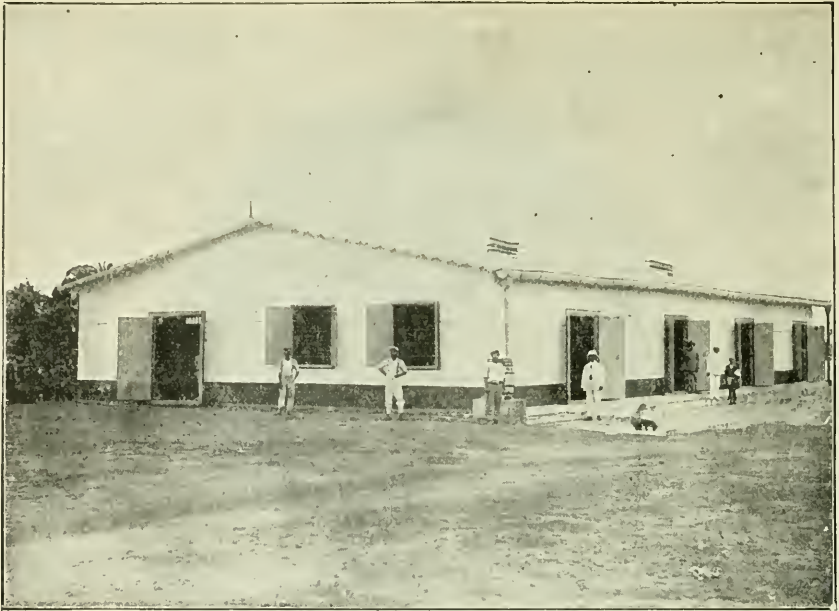
Laden und Kontorgebäude in Kribi (Süd-Kamerun), errichtet aus Patent-Baueisen-Konstruktion, eingedeckt mit „EMREX“ Astralit.
