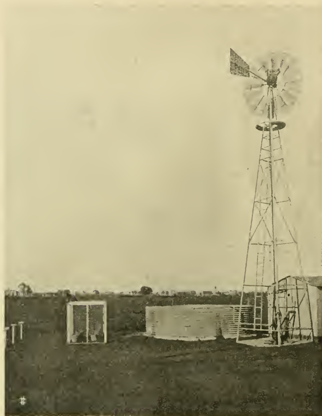
Molino a vento, pompa, motore e deposito per l'acqua di irrigazione.
