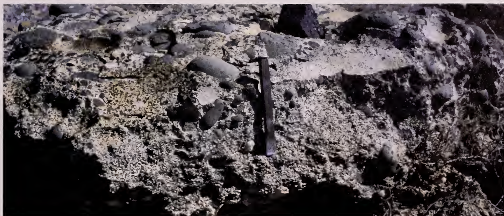
Detalle del depósito interior
