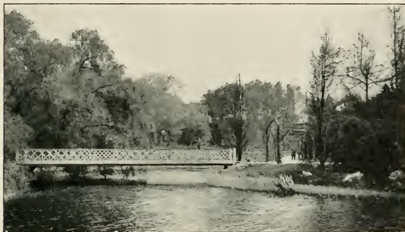
Fig. 14. Broen over Soen, til højre Løvgangen og til venstre de store Pile. (C. H. O. foto. Juni 1924).
